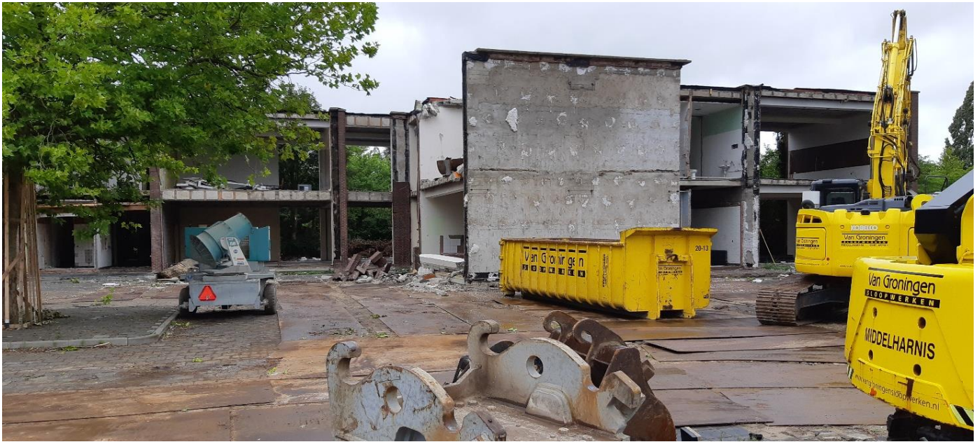
Sloop oude CSV-gebouw aan de Duikerlaan in Capelle aan den IJssel
